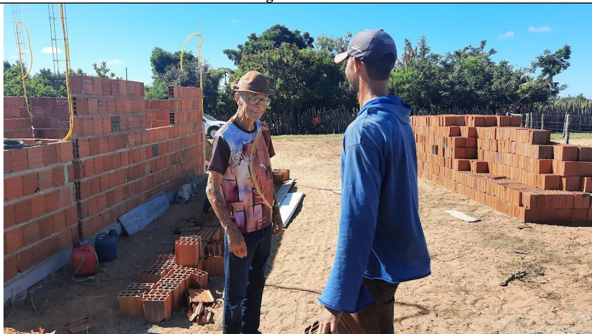
Bildunterschrift: die Mauern hochziehen
