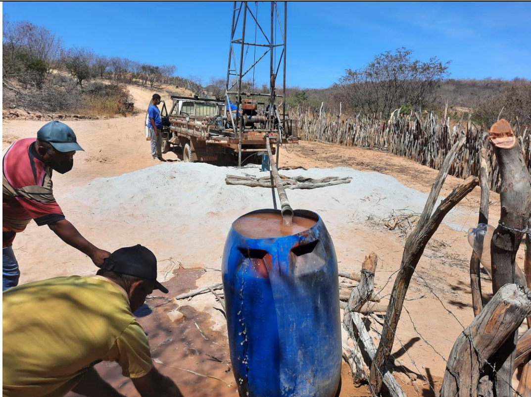
Bildunterschrift: Probe der Tiefbrunnen-Kapazität, um eine Tiefpumpe zu installieren
