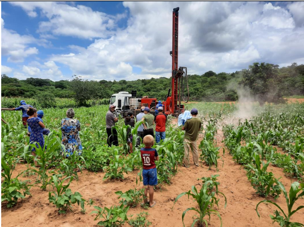
Bildunterschrift: Bohren eines Rohrbrunnens. Eine Wasseranalyse ergab, dass das Wasser für menschlichen Bedarf geeignet ist.
